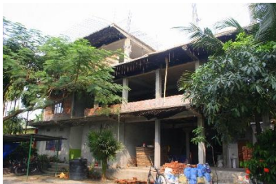
Den nya skolbyggnaden tar form
